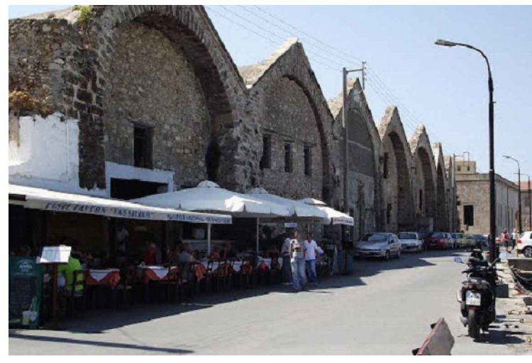
Υφιστάμενο φωτιστικό οδοφωτισμού Ανατολικής λιμενολεκάνης
